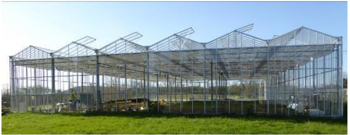
Depuis 2015, Acra est un centre de recherche sur l'aquaponie sur le lieudit Gouts. à Aiguillon (47). Constitué d'un serre verre Richel de 1000 m<sup>2</sup> avec un ordinateur de contrôle du climat, une chaudière moderne en bois et un ballon de stockage eau chaude de 60 m<sup>3</sup>. L'eau de pluie est stocké dans une cuve de 30 m<sup>3</sup>, Un puit avec pompe immergé, une borne d'eau sous pression pour arrosage agricole est installée
